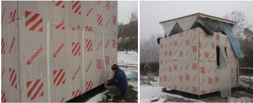
Attēls 5.4. Stendi ar nosedzošo pretvēja plāksni ārpusē pirms dekoratīvās apdares.
