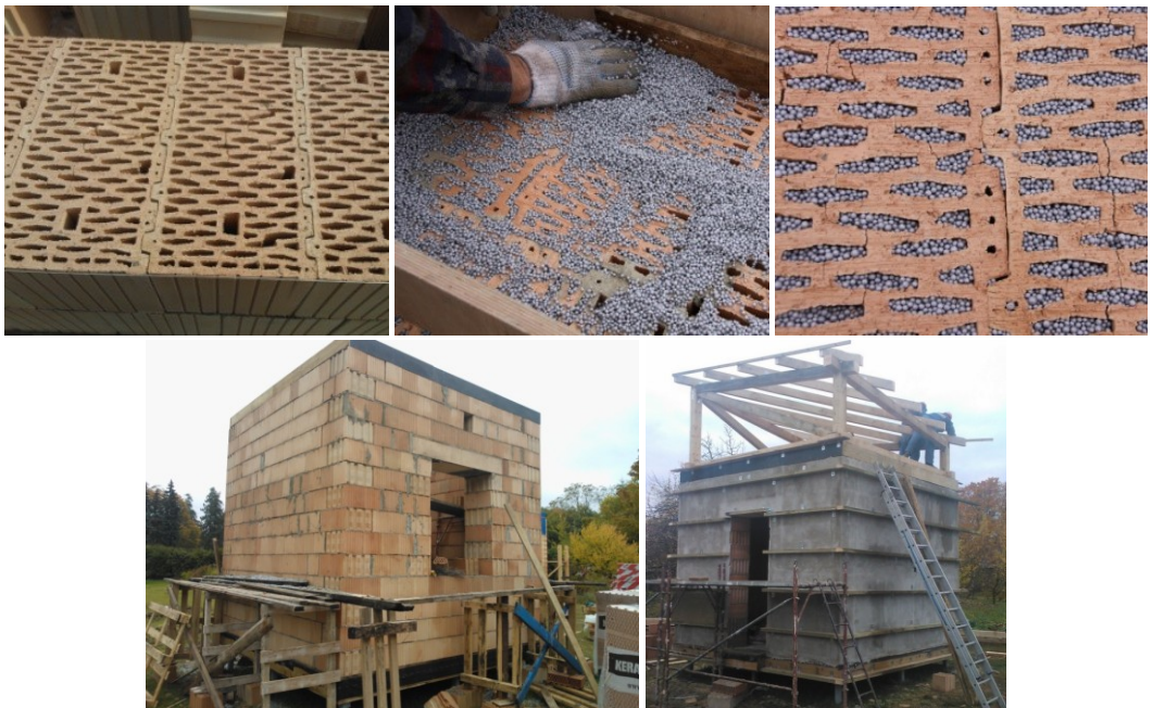
Attēls 5.8. Keramisko bloku ar pildītiem dobumiem ārsienas izbūves posmi.
