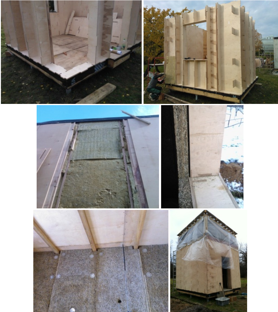
Attēls 5.6. Saplākšņa paneļu ār sienas izbūves posmi.
