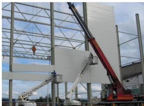
Attēls 2.86. Celtniecības paneļu piestiprināšana pie ārsienas nesošā karkasa.
