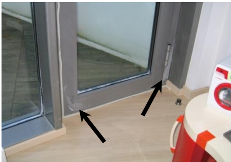
Attēls 2.18. Negatīva temperatūra uz iekšējām ārdurvju konstrukcijas virsmas.
