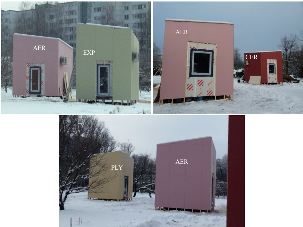
Attēls 5.11. Stendu izbūves stāvoklis pirmās termogrāfiskās pārbaudes laikā.
