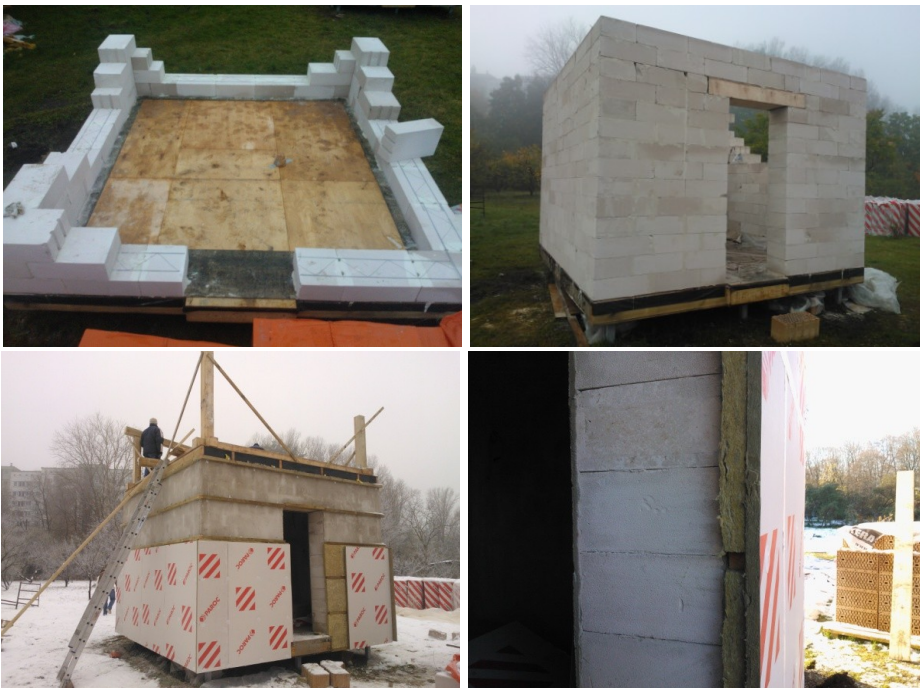
Attēls 5.5. Gāzbetona bloku ārsienas (AER) izbūves posmi.
