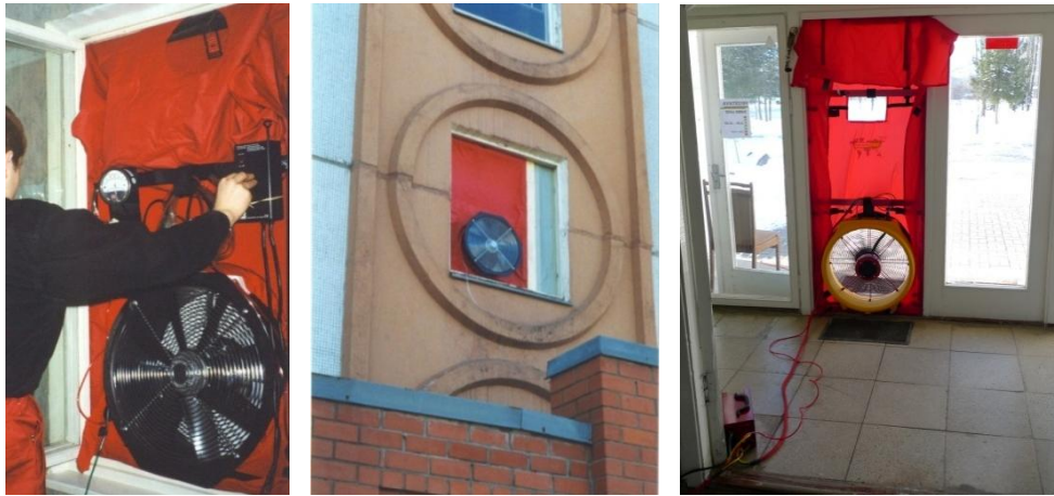
Attēls 2.98. Logā ievietotās BlowerDoor iekārtu kopskats mērījumu laikā.
