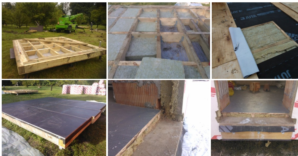
Attēls 5.1. Grīdas konstrukcijas izbūves posmi.
